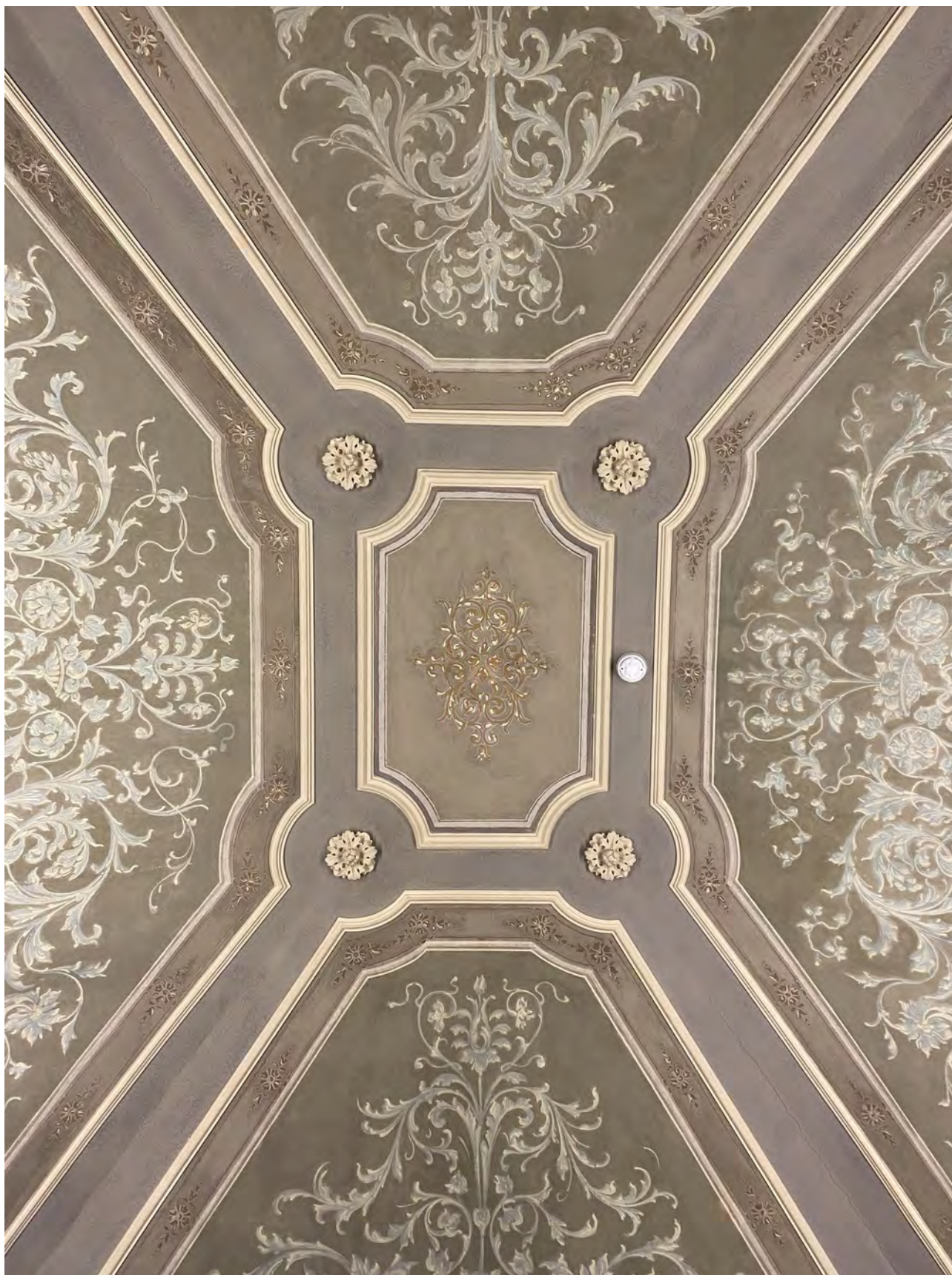
VISTA NUOVO SENSORE IMPIANTO ANTINCENDIO SU VOLTA A PADIGLIONE DI LOCALE AL PIANO RIALZATO. IL PRECEDENTE SENSORE ERA POSIZIONATO SULL'AFFRESCO CENTRALE IN POSIZIONE DECENTRATA
