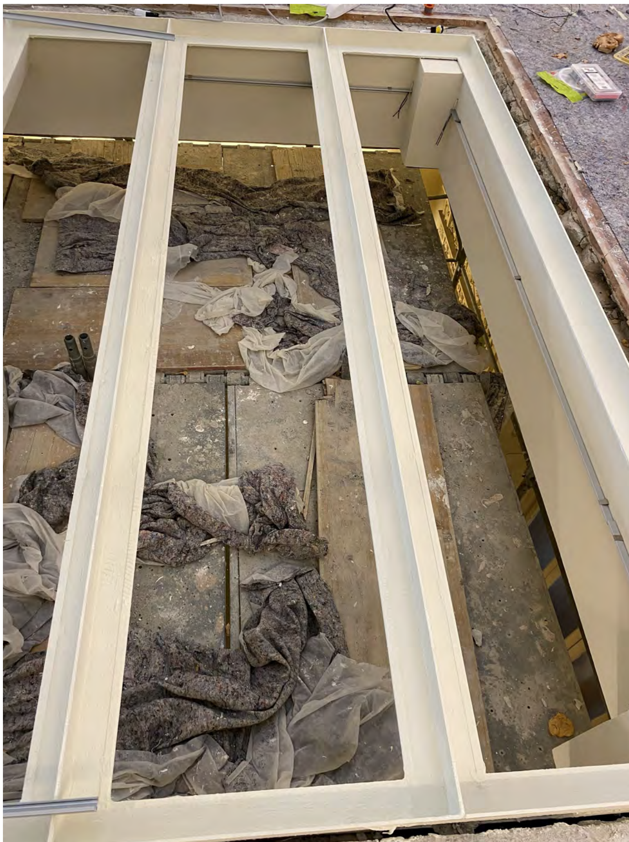
VISTA VERNICIATURA IGNIFUGA TELAIO E RIPOSIZIONAMENTO ILLUMINAZIONE ESISTENTE
