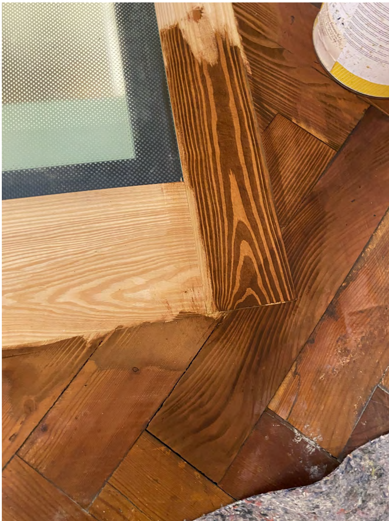
VISTA PROVA TINTA ELEMENTI LIGNEI
