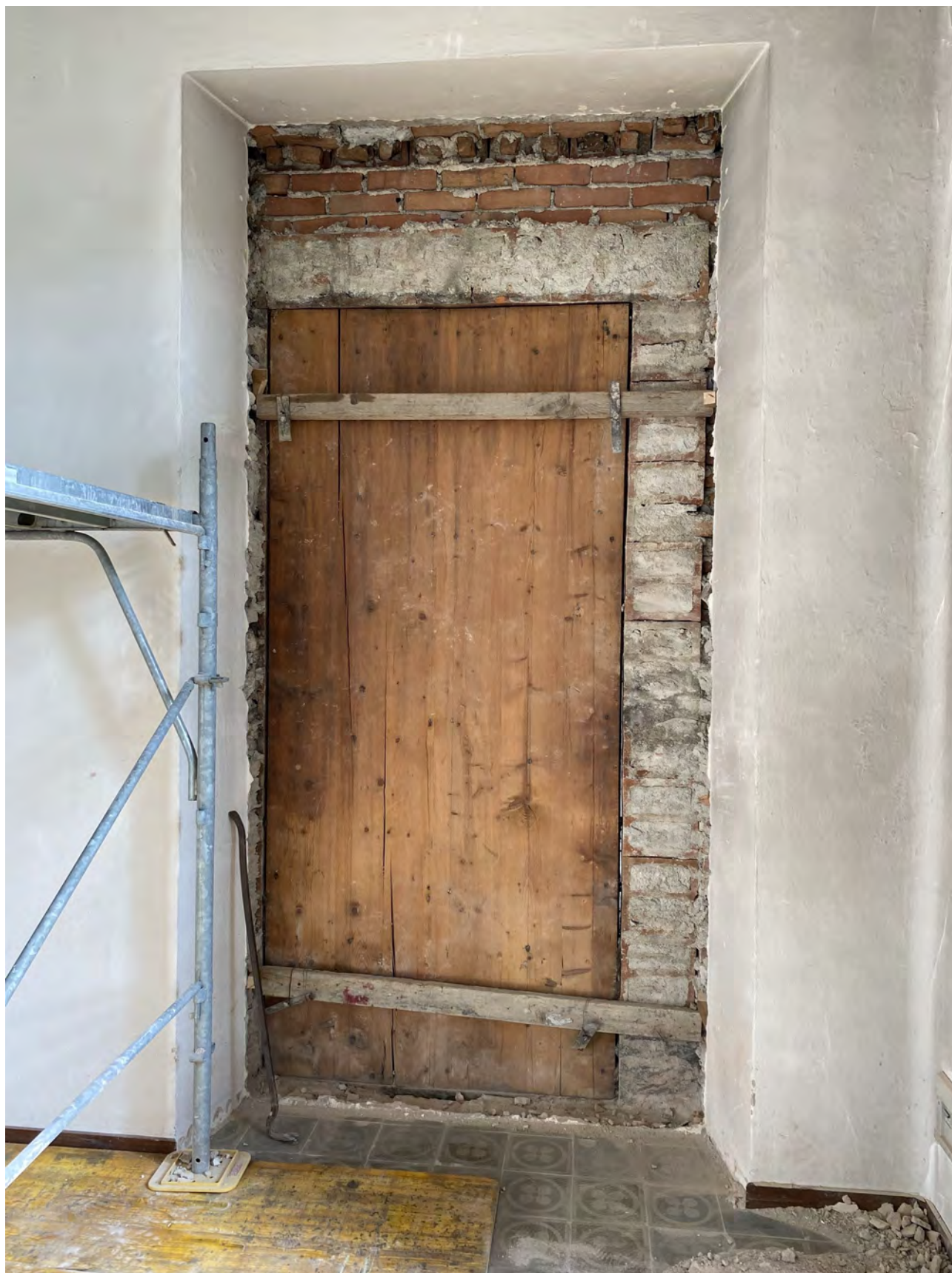
VISTA POSTUMA ALLA RIMOZIONE DEL TAMPONAMENTO
