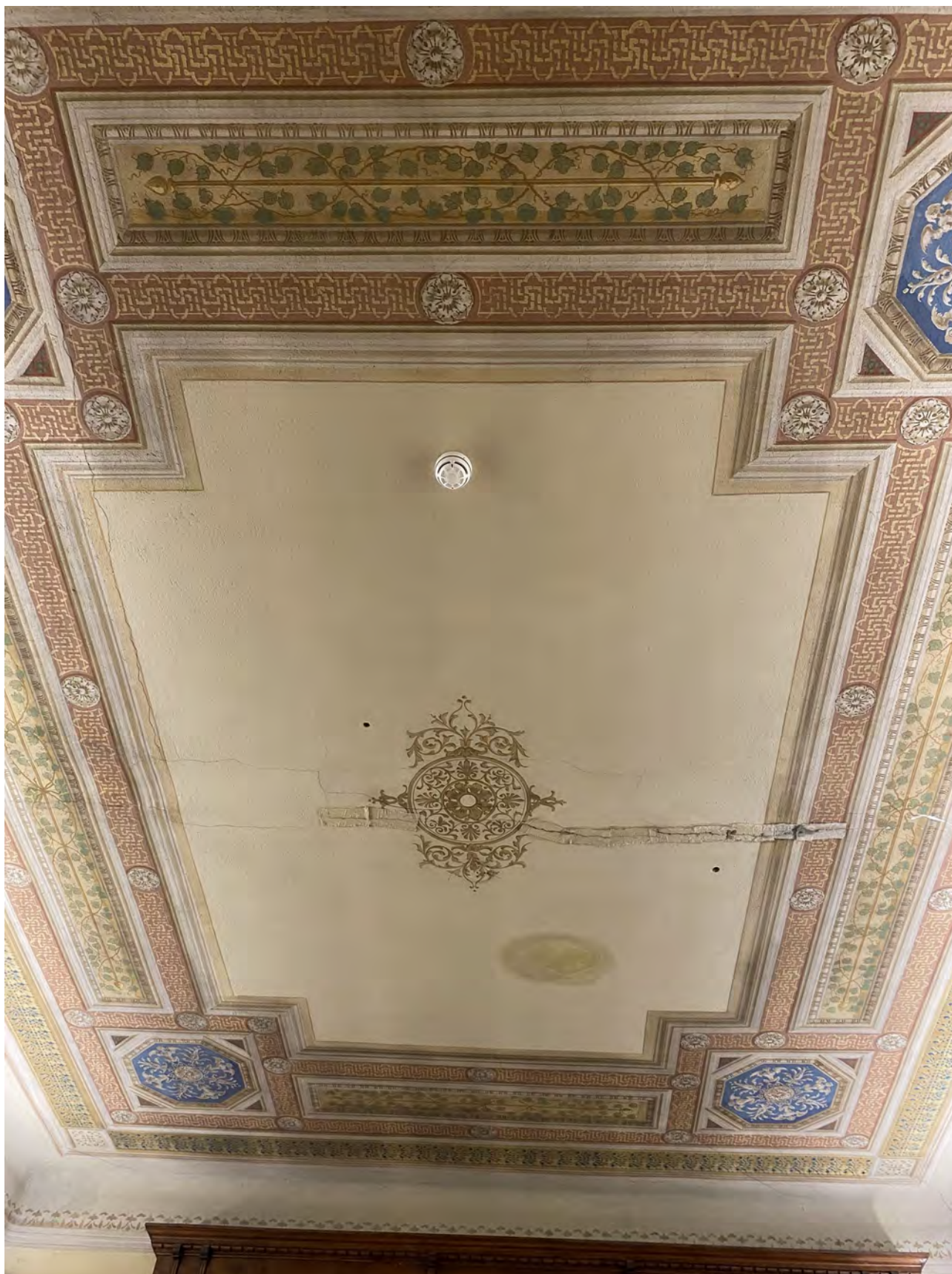
VISTA NUOVO SENSORE IMPIANTO ANTINCENDIO SU SOFFITTO PIANO DI LOCALE AL PIANO PRIMO. LO SPOSTAMENTO DEL SENSORE IN QUESTO CASO È STATO DETTATO DAL FATTO CHE QUELLO VECCHIO SI TROVAVA IN CORRISPONDENZA DELLA LESIONE A SOFFITTO
