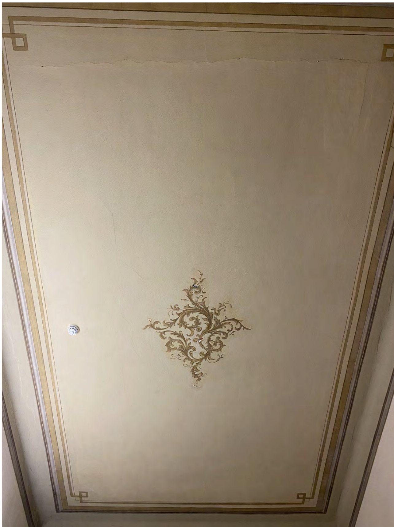
VISTA NUOVO SENSORE IMPIANTO ANTINCENDIO SU SOFFITTO PIANO DI LOCALE AL PIANO PRIMO. IL PRECEDENTE SENSORE ERA POSIZIONATO SULL'AFFRESCO CENTRALE IN POSIZIONE DECENTRATA
