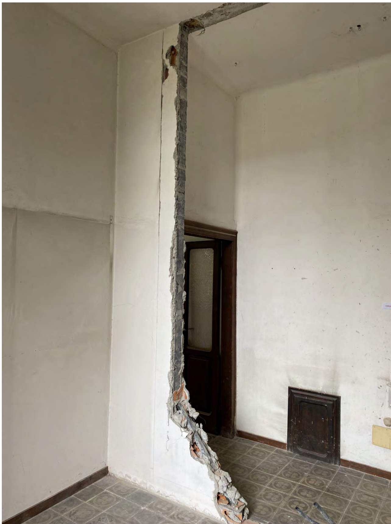
VISTA DEL PILASTRO E DELLA SETTA EMERSI DURANTE LA RIMOZIONE DELLA MURATURA
