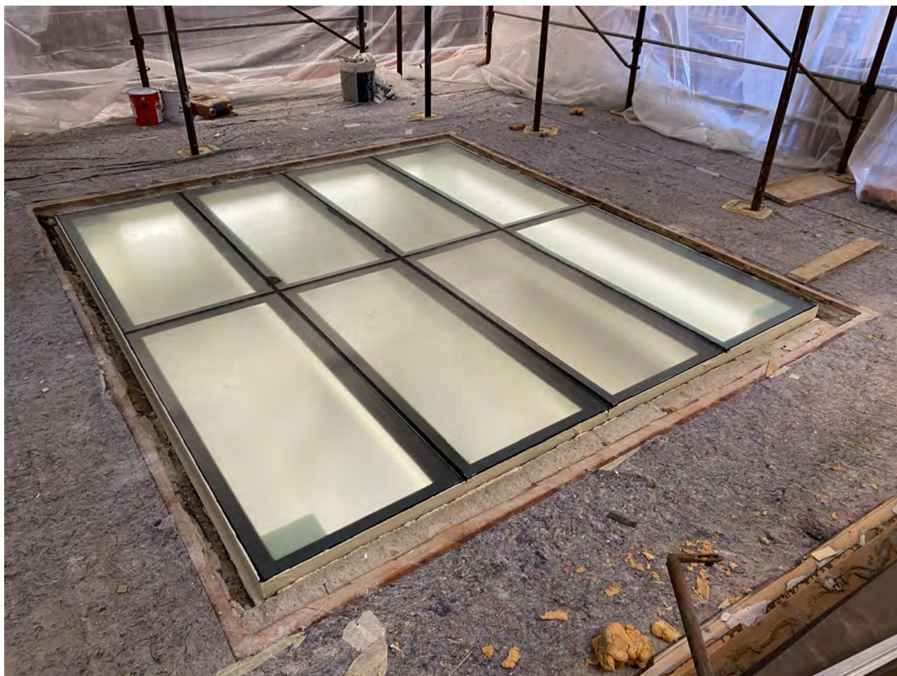
VISTA POSA PAVIMENTAZIONE IN VETRO CALPESTABILE REI 60
