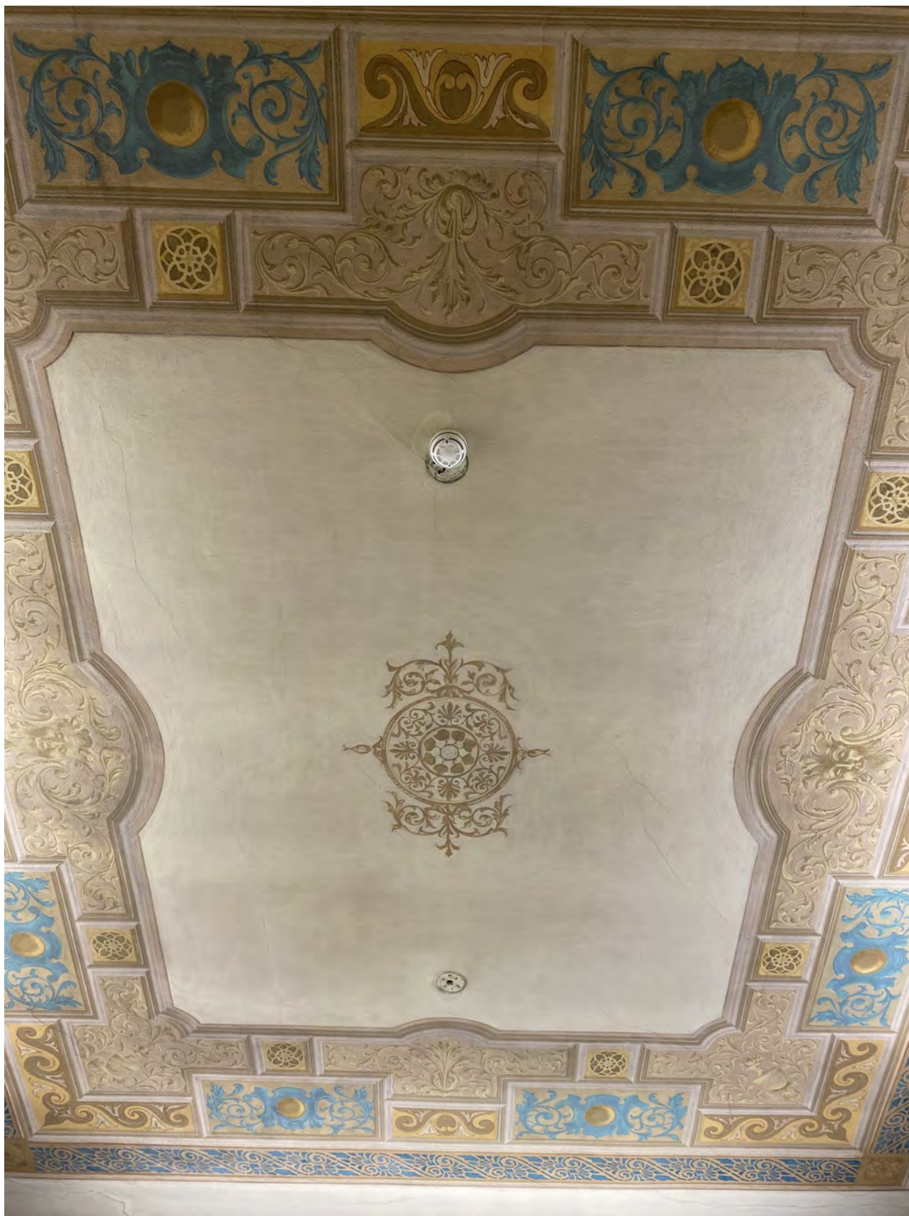
VISTA NUOVO SENSORE IMPIANTO ANTINCENDIO SU SOFFITTO PIANO DI LOCALE AL PIANO PRIMO. IN QUESTO CASO IL SENSORE È STATO POSIZIONATO IN CORRISPONDENZA DEL VECCHIO FISSAGGIO DEL LAMPADARIO A SOFFITTO
