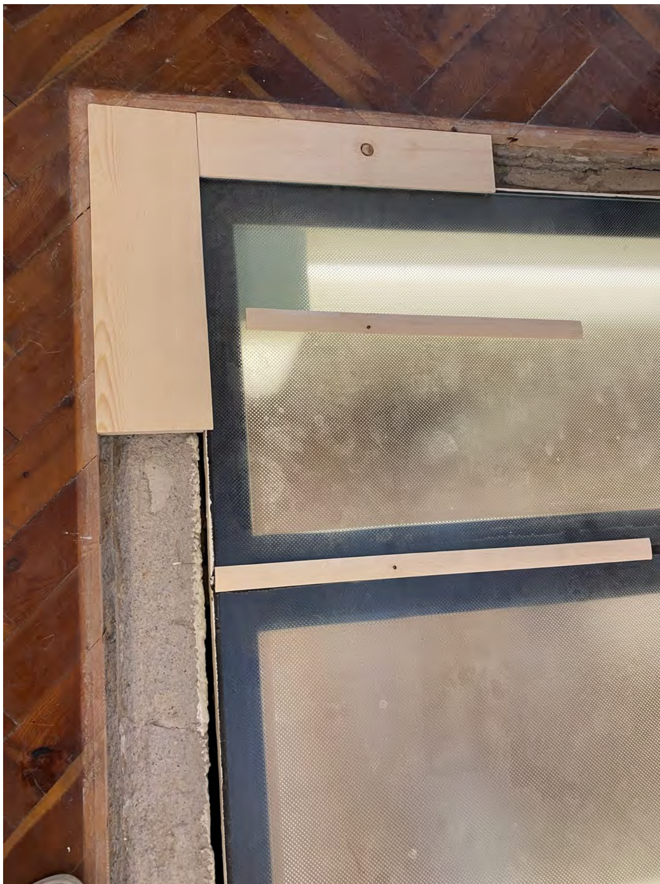
VISTA PROVA ELEMENTI DI RIPRISTINO LACUNE DEL PAVIMENTO E COPERTURA SILICONE IGNIFUGO E SERIGRAFIA
