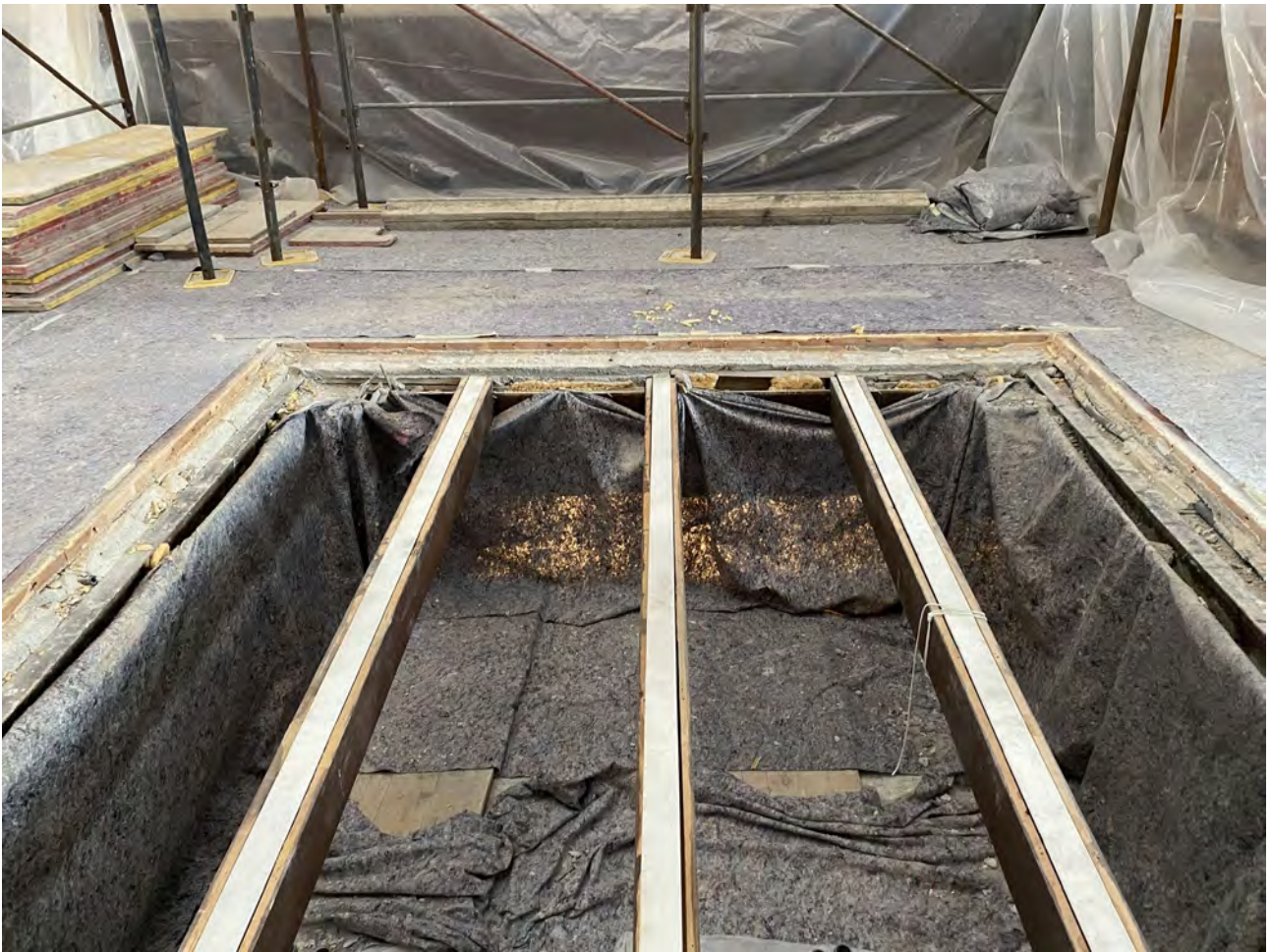
VISTA DOPO LA RIMOZIONE DEL MANUFATTO IN CLS E DEI MURI PERIMETRALI IN BLOCCHI DI CLS
