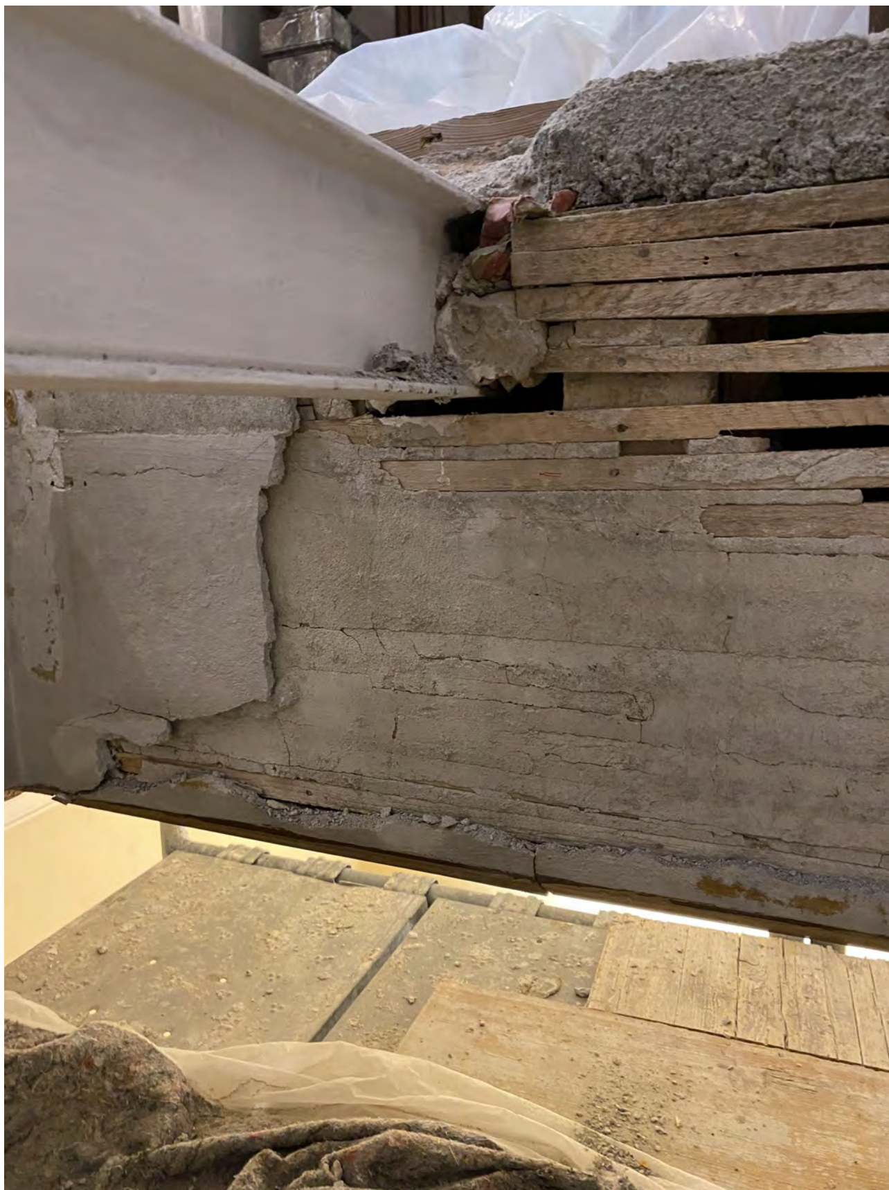
VISTA LACUNE DI INTONACO E SUOI DISTACCAMENTI CELATI DIETRO IL RIVESTIMENTO LIGNEO
